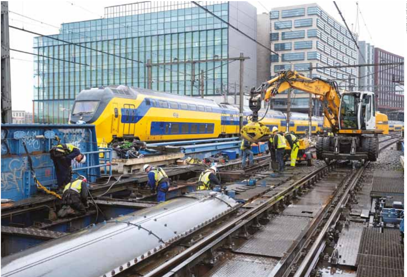
ProRail-werknemers bezig met spoorwerkzaamheden
